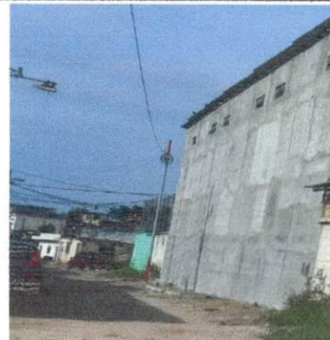
Foto 4: 204 metros trabajados cernido y repello de pared.
