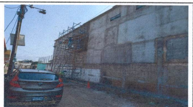
Foto4 . Continuacion de inicio de repello.
