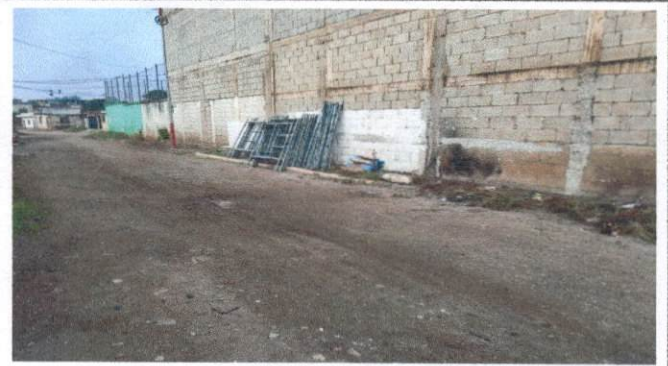
Foto 2: Andamio para iniciar el trabajo de repello de pared.
