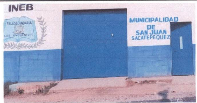
Foto 4: Área de reparación de banqueta.
