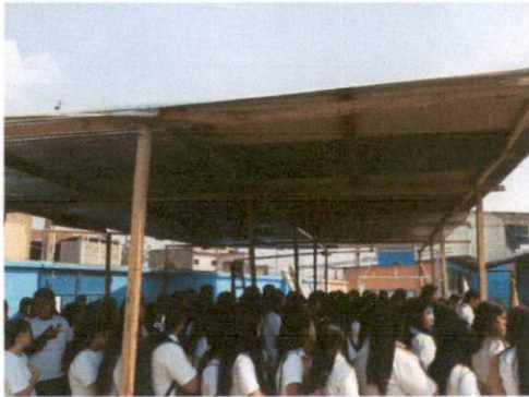
Foto 3: Sustitución e intalación de estructura portante de metal 180 m2. Para seguridad de la comunidad educativa.
