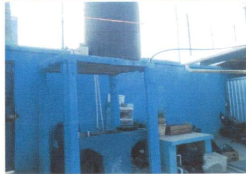
Foto 6: La base que tiene esta en mal estado(agrietada) Se sustitución de la base del tinaco de agua, por seguridad de la comunidad educativa.
