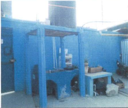
Foto 5 Sustitución de base de concreto por estructura metálica para colocación de 2 tinacos para distribución de agua de 1.22 m x 2.44 m x 2.60m.
