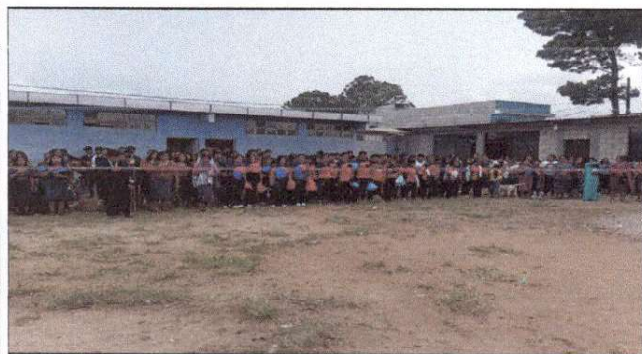
Foto 3: Área de la cancha y patio del establecimiento que necesita reparación con torta de concreto.
