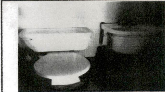
Foto 1: SUSTITUCIÓN DE SANITARIO Y LAVAMANOS EN EL AREA INFERIOR IZQUIERDA A LA PAR DEL SALÓN DE SEGUNDO B Y C
