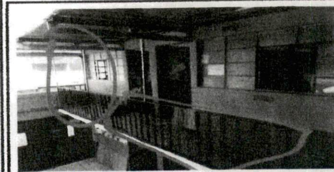
Foto 5: REFORZAR BARANDA CON TUBOS DE HIERRO Y SOLDAR LA PARTE QUE HACE FALTA EN EL LADO DERECHO DEL SEGUNDO NIVEL, FRENTE AL SALÓN DE TERCERO B Y C.
