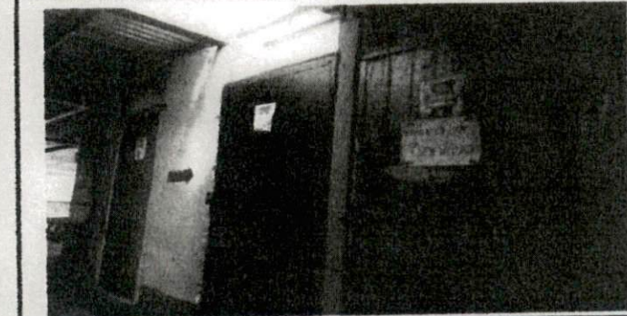
Foto 6: SUSTITUCIÓN DE DOS PUERTAS DE SANITARIOS, DE MADERA POR METAL EN EL SEGUNDO PISO, FRENTE A PRIMERO B.
