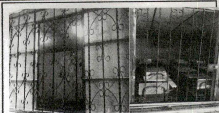
Foto 13: MANTENIMIENTO DE 2 BALCONES EN SEGUNDO PISO EN EL GRADO DE SEGUNDO A
