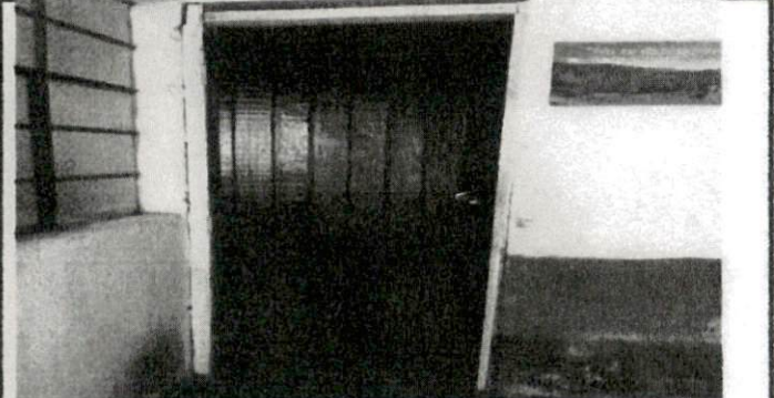
Foto 8: SUSTITUCIÓN DE PUERTA DE MADERA POR METAL PRIMER PISO, FONDO DE LA COCINA.
