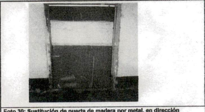
Foto 30: Sustitución de puerta de madera por metal, en dirección
