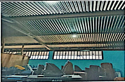
Foto No. 11 Corresponde al salón donde se colocará cielo falso.
