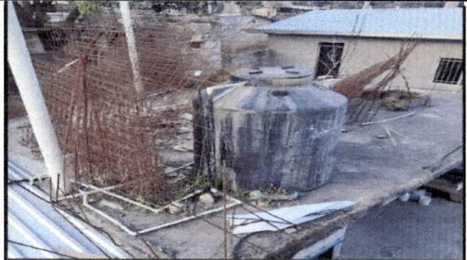
Foto 2: Parte izquierda del lugar donde se ampliará la cocina.
