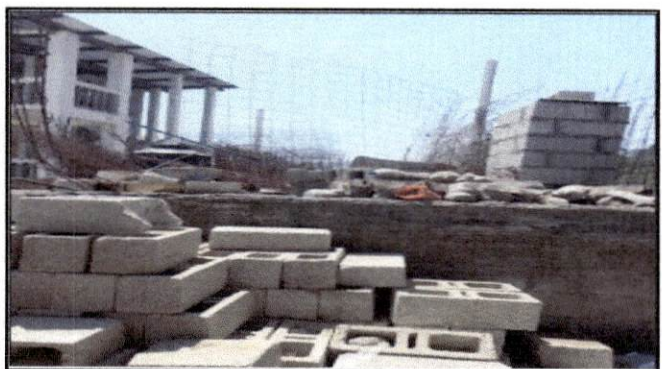
Foto 4: Entrada del salón de la cocina parte derecho frontal.
