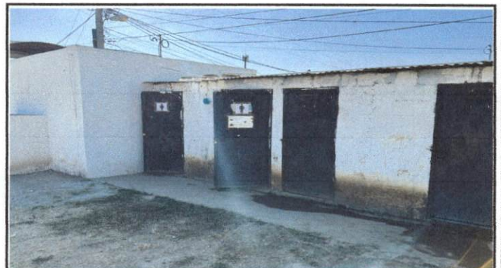
Foto 4: Reparación de banqueta de concreto, ya que por el agua se ha deteriorado
