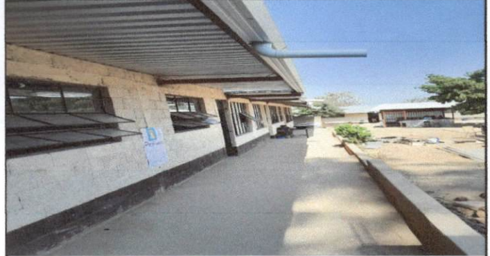
Foto 8: Cambio de la estructura metalica de las ventanas de los módulos 3, 4, 5, 6 y 7, ya que limitan la claridad y el paso de aire
