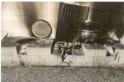
Foto1: reparación de la estufa rural y chimeneas.
