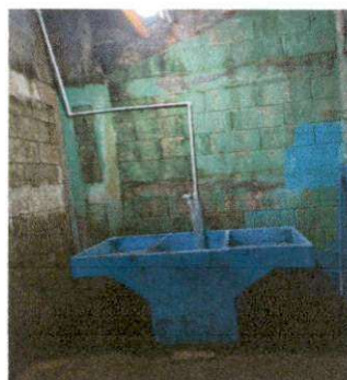
Foto 4: Instalación de azulejo en pared dañada por la humedad
