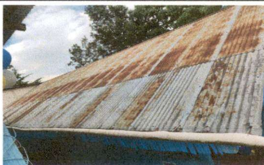
Foto 3: Mantenimiento de láminas limpieza, lijar y pintar.
