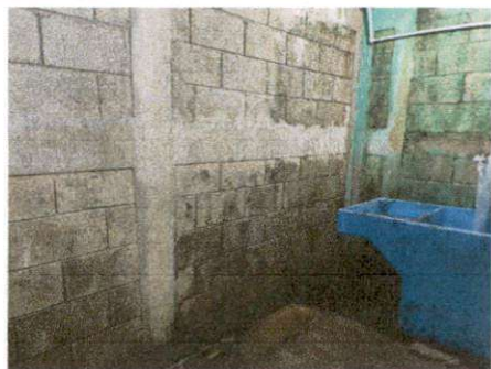
Foto 5: Instalación de un área de lavado de manos digno
