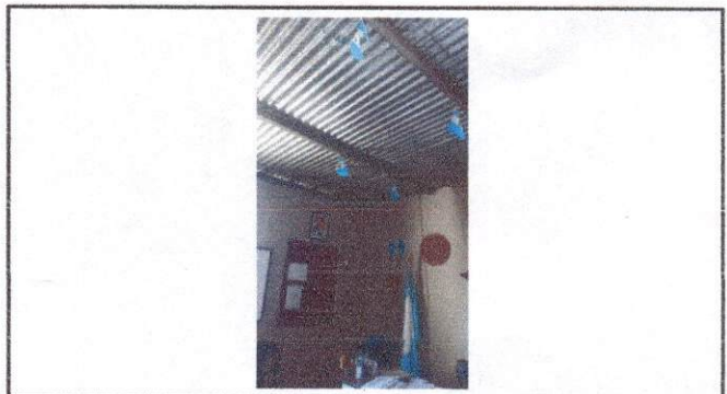
Foto 4: Foto del techo que se sustituirá para colocar la losa
