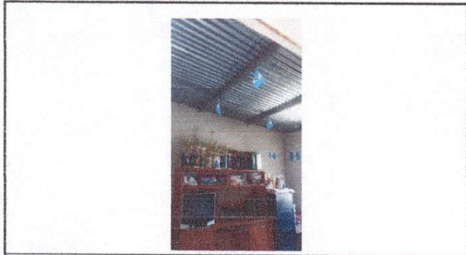
Foto 3: Foto del techo que se sustituirá de la losa
