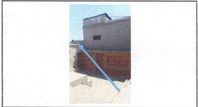
Foto 2: Entrada hacia el techo que será sustituido
