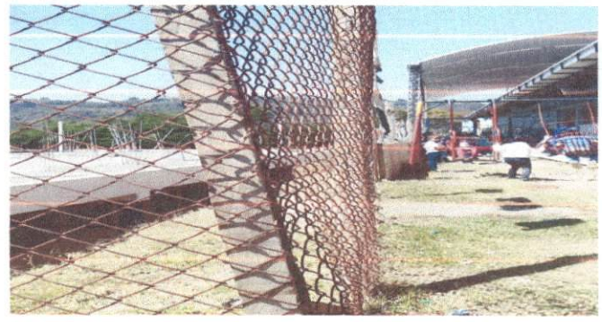
Foto 2: Area donde se edificará muro de contención.
