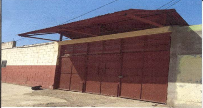
FOTO 2 Sustitución de porton de metal, debido a que se encuentra en mal estado, se dificulta al momento de abrir para ingreso al establecimiento, se encuentra picada en la parte de debajo de la misma.
