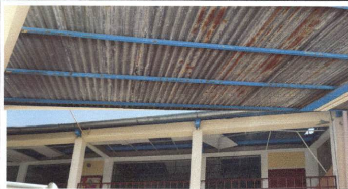
FOTO 1 Sustitución de lámina troquelada, debido al deterioro que tienen po los años y el deterioro de la estructura cielo falso y la caída de los mismos.
