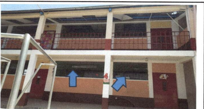
FOTO 5 Fabricación e instalación de balcones de hierro, debido a que es el salón de computación.
