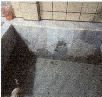
Foto 11: Reparación de pila de cocina
