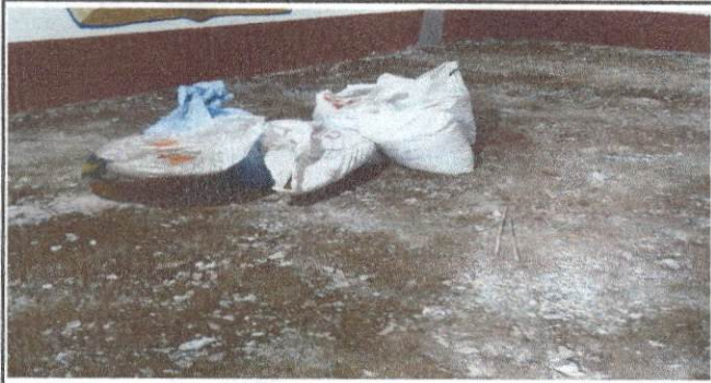
Foto 1: Sustrucción de torta de cemento por piso cerámico en un salón que ocupa la Dirección.
