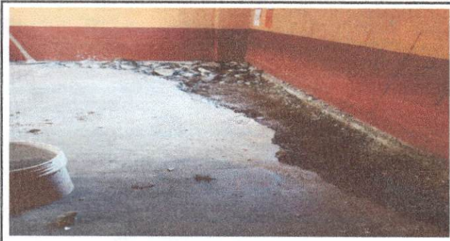
Foto 3: Sustrucción de torta de cemento por piso cerámico en el salón de Tercero Primaria.
