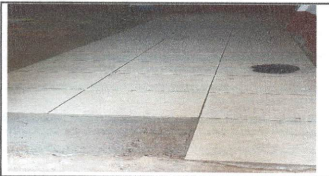
Foto 5: Sustrucción de torta de cemento por piso cerámico en el salón de Sexto Primaria.
