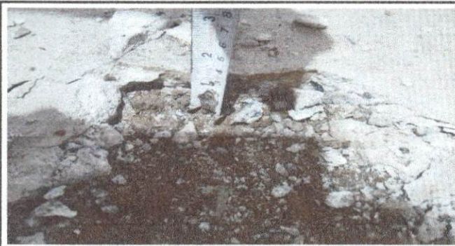
Foto 2: Sustrucción de torta de cemento por piso cerámico en el salón de Segundo Primaria.
