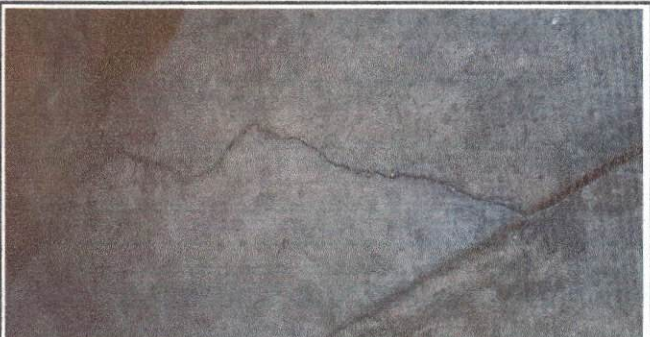
Foto 4: Sustracción de torta de cemento por piso cerámico en el salón de Cuarto Primaria.
