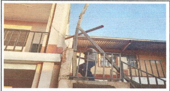
Foto 7: Sustitución de bajadas de agua pluvial tubo PVC 3".
