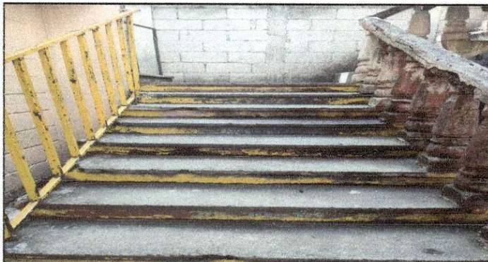
Foto 5: Sustitución de barandas de metal
