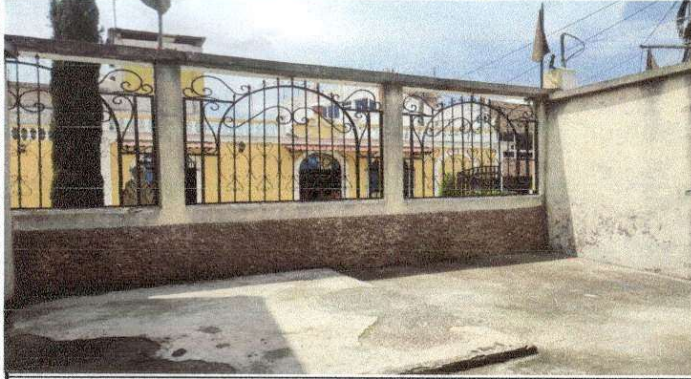
Foto 1: Reparación de muro perimetral
