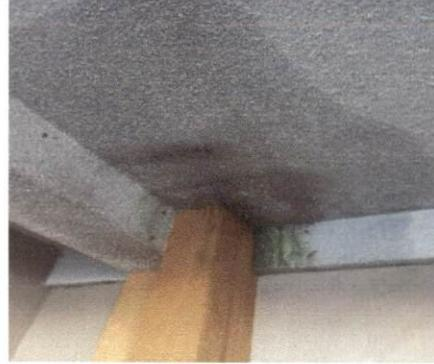
Foto 2: Filtración de humedad en losa, ventanas sin paletas de vidrio
