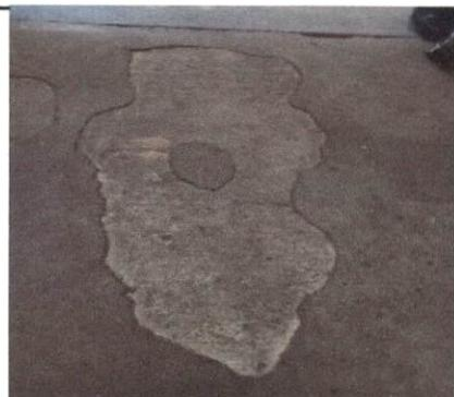
Foto 6: Patio en mal estado con desprendimiento de cemento ocasionando peligro a caminar, puertas picadas en mal estado
