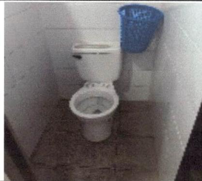
Foto 4: Sanitario, en mal estado con fugas.
