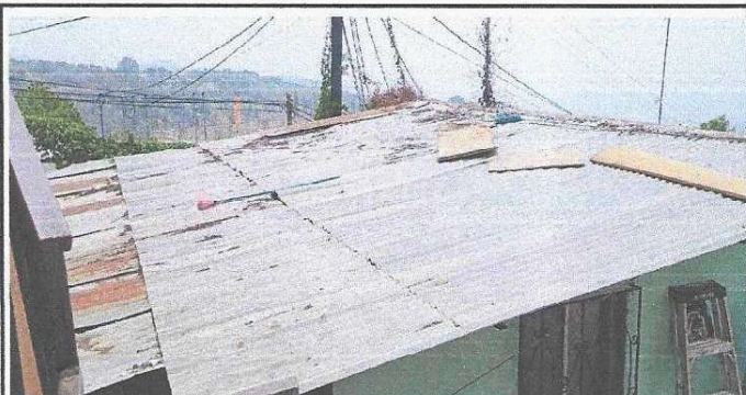
Foto 10: Sustrucción de lámina, por lámina troquelada aluzinc calibre 26
