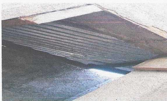
Foto 9: Sustrucción de plafoneras
