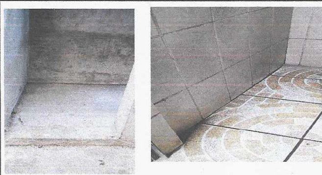
Foto 8: Reparación o sustitución de azulejos
