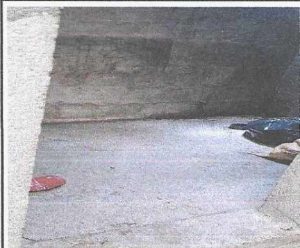
Foto 7: Sustrucción de inodoros
