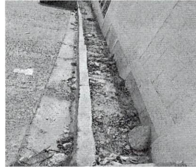
Foto 2: Reparación de banqueta a orilla de calle
