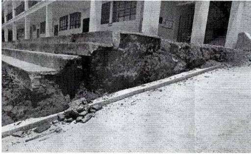
Foto 1: Vista lateral suroriente de graderio hacia cancha deportiva.
