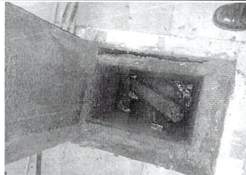
Foto 6: Mantenimiento de caja de registro de drenaje
