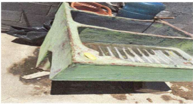
Foto 3: Sustitución de pila de cemento de dos lavaderos.
