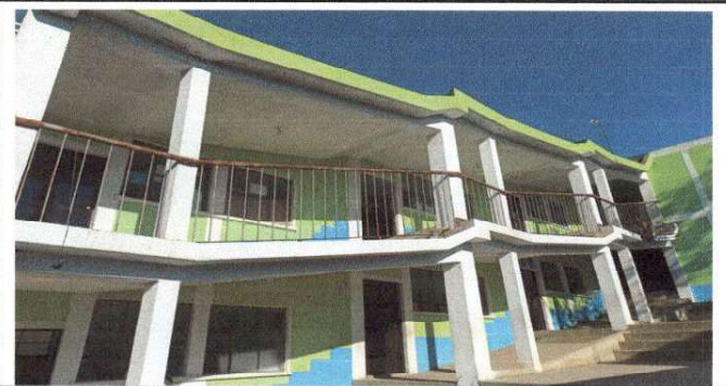
Foto 6: Mantenimiento de baranda de metal.
