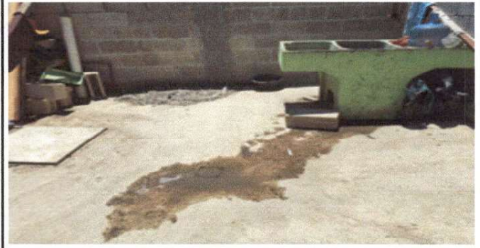
Foto 2: Sustitución de tubería línea principal, llave cheque y llave de chorro.
