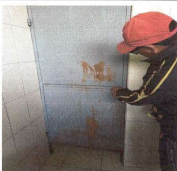
Foto 5: Módulo de baños de niños y niñas, 6 puertas de metal, mantenimiento a estructura (lijado, cambio de tubo, cepillado, sujeciones, aplicación de pintura)
