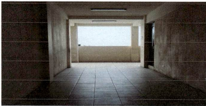
FOTO 5: Sustitución de puerta
