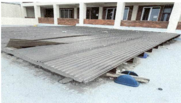
FOTO 3: Sustitución de lamina
