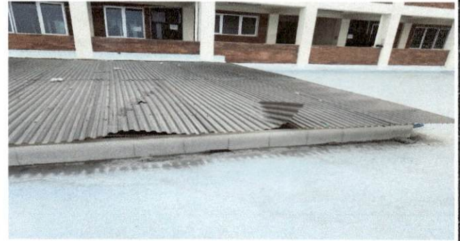
FOTO 2: LEVANTADO DE MURO PARA TECHO DE PERGOLA
