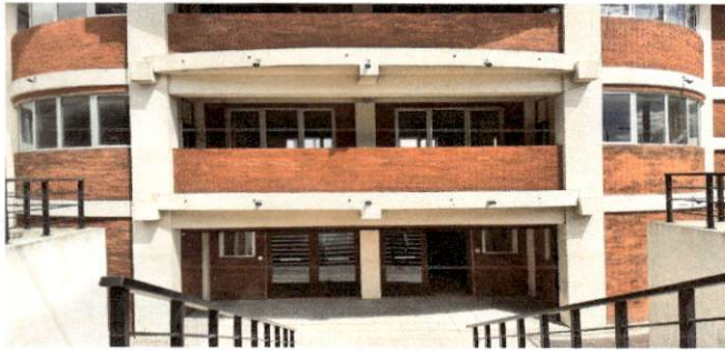
FOTO 1: INGRESO AL ESTABLECIMIENTO
