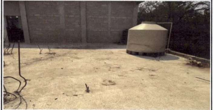
Foto 2: area donde será colocada la cubierta de lámina.
