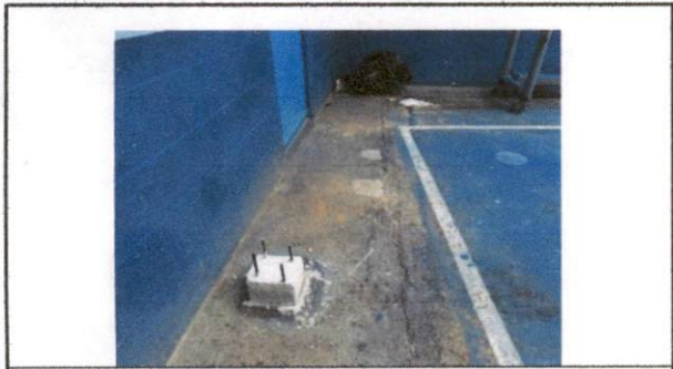
Foto 3: REPARACION DE BASES
