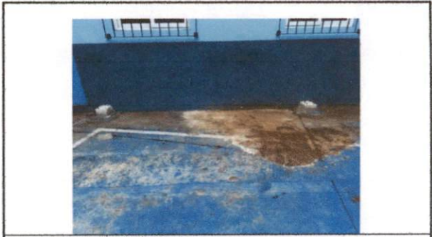
Foto 4: REPARACION DE BASES
