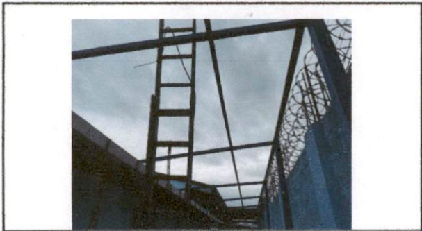
Foto 1: PREPARACION DE ESTRUCTURA PORTANTE
