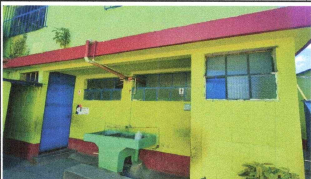
Foto 3: Pila y modulo de baños
