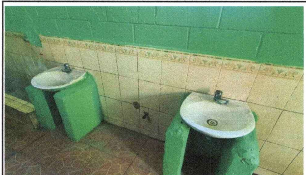
Foto 4: Lavamanos en sanitarios
