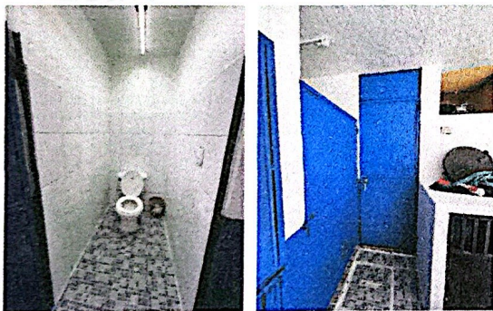
Foto 9: Instalación de inodoros + azulejo + suministro e instalación de puerta en baño guardián.
