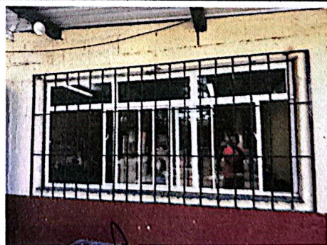
Foto 6: Suministro e instalación de ventana en dirección.
