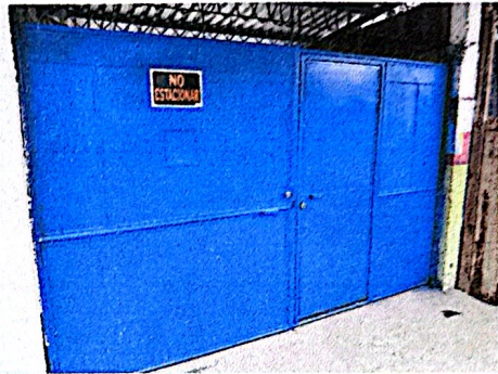
Foto 2: Mantenimiento de portón.
