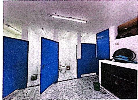
Foto 8: Mantenimiento a puertas de baños + instalación de piso y azulejo.
