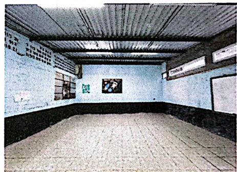
Foto 10: Suministro e instalación de piso cerámico en salón.
