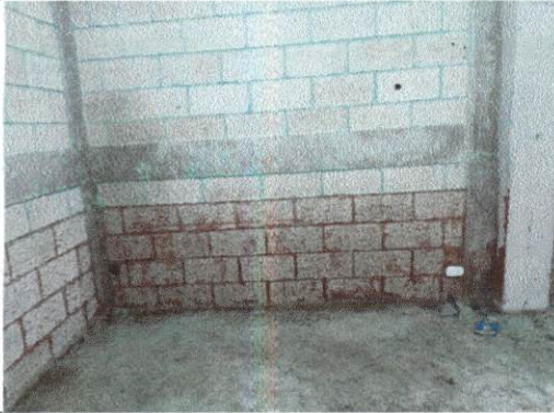
Foto1: picado y raspado para preparar para el repello
