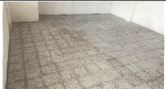
Foto 6: Instalación de piso granito
