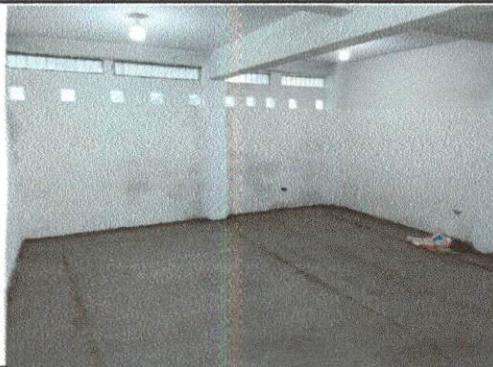
Foto 5: mezción para piso granito
