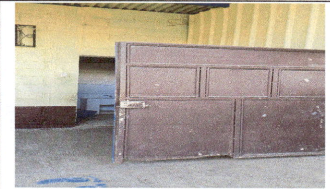
Foto 3: COLOCACION Y SUMINISTRO DE PUERTA DE METAL
