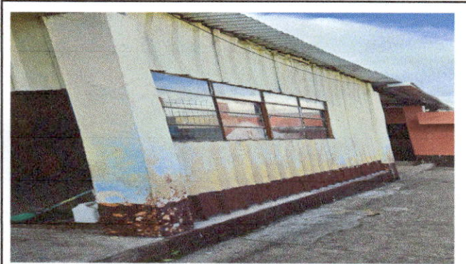
Foto 9: SUMINISTRO Y COLOCACION DE BLOCK CON REFUERZO ESTRUCTURAL
