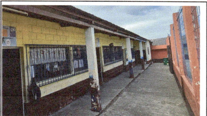
Foto 4: COLOCACION DE CAJAS DE REGISTRO PARA BAJADS DE AGUA PLUVIAL.
