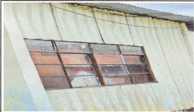
Foto 7: SUMINISTRO Y COLOCACION DE VENTANA DE PVC
