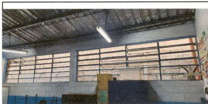
Foto 5: Gracias a que se cuenta con el espacio a un costado del aula, se puede ampliar el aula para que se cuente con más espacio para comodidad de los estudiantes.
