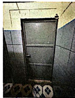
Foto 6: Mantenimiento a puertas metálicas de baños + instalación de puerta en bodega.
