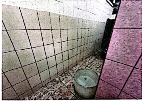
Foto 10: Suministro e instalación de azulejo + aplicación de pintura.
