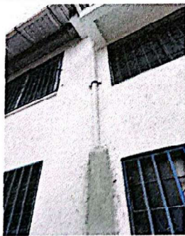
Foto 5: Instalación de tubería de descarga pluvial, con protección de concreto.
