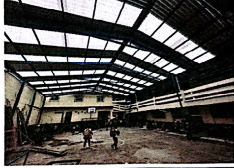
Foto 8: Suministro e instalación de estructura de soporte para techo + lámina
