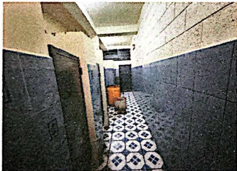
Foto 3: Suministro e instalación de azulejo baño de niños.
