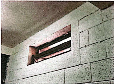
Foto 1: Apertura de vano para ventilación en baño + Ventana tipo sifón.
