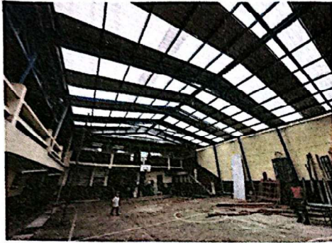
Foto 7: Instalación de tijeras para techo + lámina troquelada de aluzinc y policarbonato.
