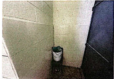
Foto 4: Colocación de Azulejo baño de niñas.
