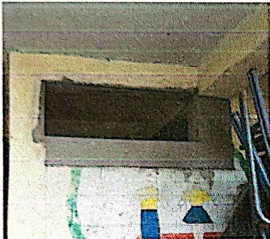
Foto 1: Apertura de vano para ventilación en baño.
