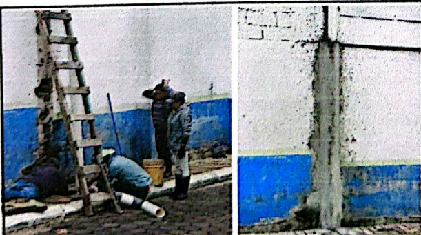
Foto 5: Instalación de tubería de descarga pluvial, con protección de concreto.
