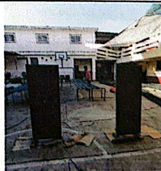
Foto 6: Mantenimiento a puertas metálicas de baños.
