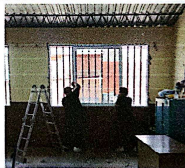
Foto 10: Suministro e intalación de ventanería UPVC.
