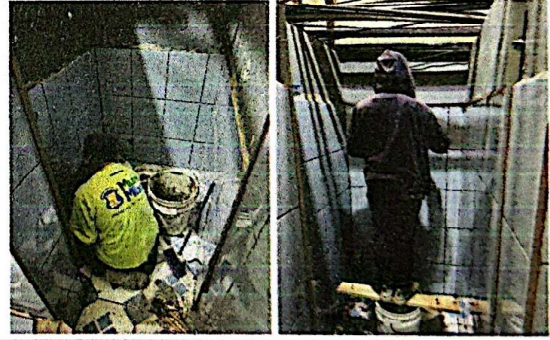
Foto 4: Colocación de Azulejo.
