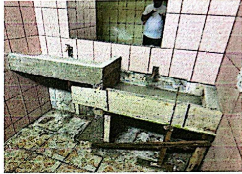
Foto 2: Fabricación de pileta en baño de niñas.
