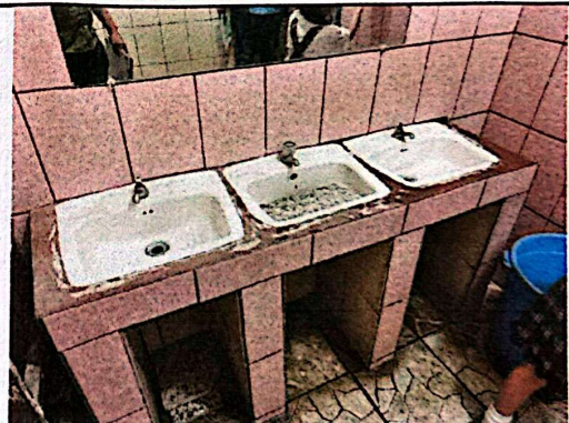
Foto 4: Se realizará el cambio de las llaves de los lavamanos ya que estas actualmente no funcionan.
