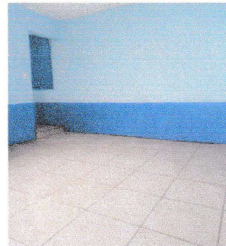
Foto 4: Bodega pintada y piso colocado.
