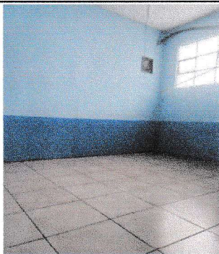
Foto 5: Salón de educación física pintado y piso colocado.
