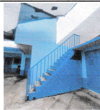
Foto 12: Baranda de escaleras pintadas.
