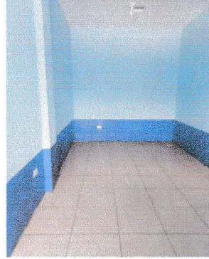
Foto 2: Salón de maestros pintado y piso colocado.
