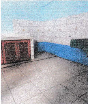
Foto 3: Cocina pintada y piso colocado.
