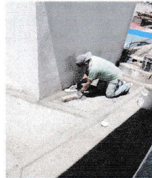
Foto 6: Colocación de pañuelos en terraza.
