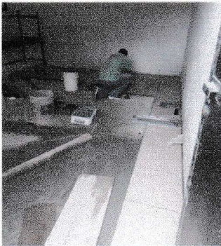
Foto 5: Colocación de piso en salón de educación física.
