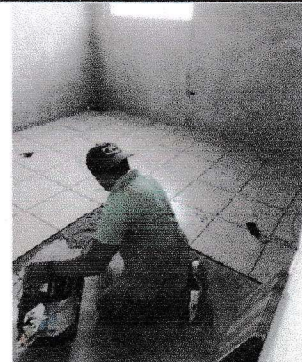
Foto 4: Colocación de piso en bodega.
