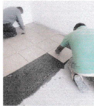
Foto 2: Colocación de piso en salón de maestros.
