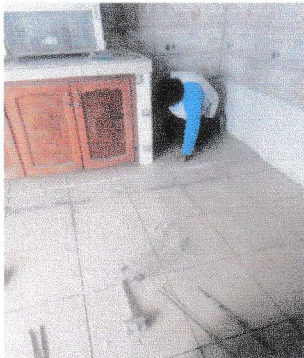
Foto 3: Colocación de piso en cocina.
