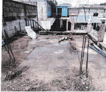
Foto 1: Espacio destinado para módulo de 02 sanitarios.
