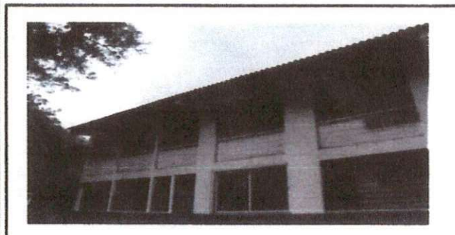
Foto 5: colocar canales parte de atrás del módulo #2
