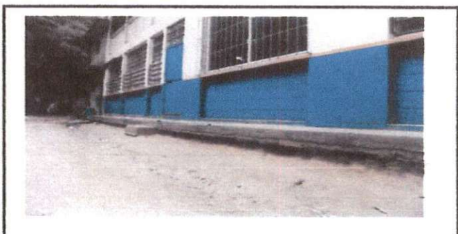
Foto 6: Alinear tierra, colocar torta de cemento
