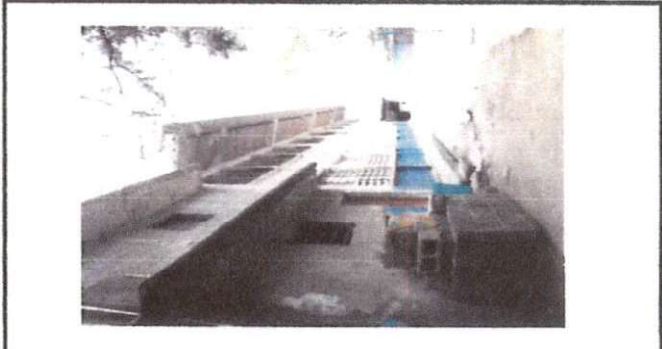
Foto 2: Colocación canales parte de atrás del módulo #2
