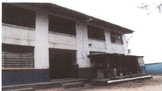
Foto 7: Colocación de canales módulo #2
