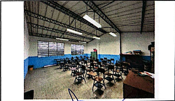
Foto 6: Suministro y aplicación de pintura en interior de salón de clases.
