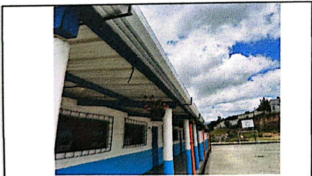
Foto 5: Suministro e instalación de canal pluvial.
