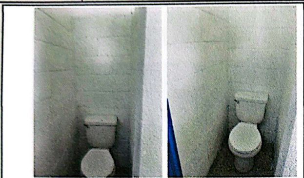
Foto1: Suministro e instalación de inodoros + pintura.
