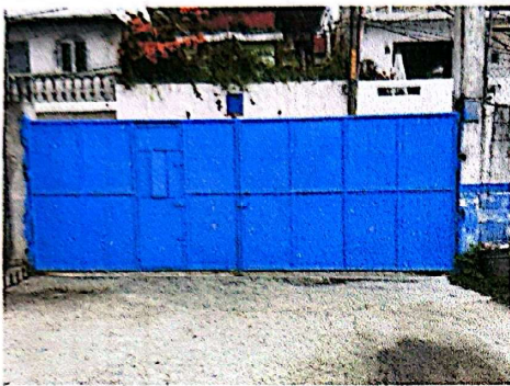
Foto 7: Mantenimiento de portón en ingreso principal.
