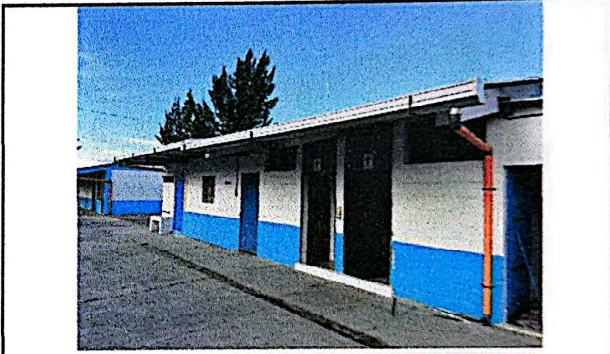
Foto 4: Suministro e instalación de canal pluvial + aplicación de pintura.
