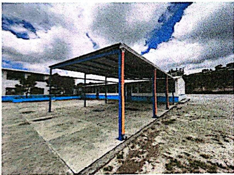
Foto 9: Suministro e instalación de estructura para techo.
