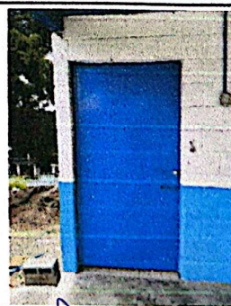
Foto 6: Mantenimiento de puerta, incluye, lijado y pintura.
