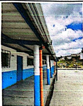
Foto 7: Suministro e instalación de canal pluvial + bajadas de agua.
