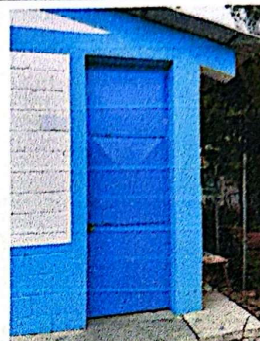
Foto 2: Mantenimiento a puerta de cocina actual, incluye lijado y pintura
