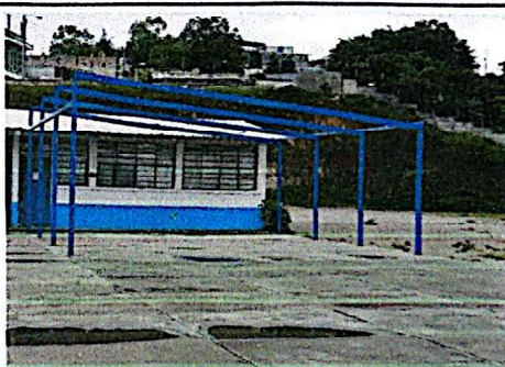
Foto 10: Armado de estructura para ampliación de techo, se evalúan los anclajes y la soldadura.
