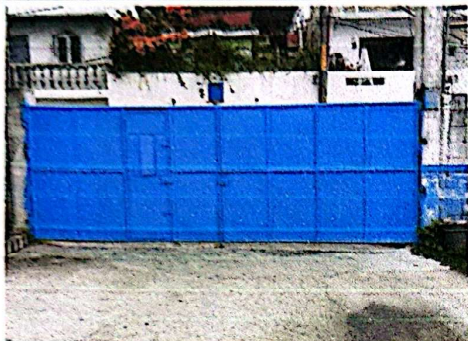
Foto 1: Mantenimiento de Portón, incluye lijado y pintura.
