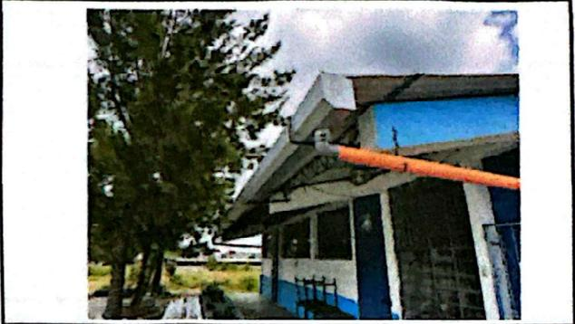
Foto 8: Tubería de PVC para descarga pluvial, con sus respectivos anclajes.
