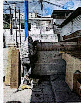
Foto 4: Encofrado y fundición de solera intermedia.
