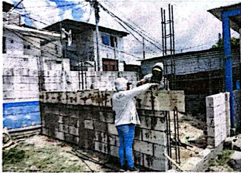
Foto 3: Encofrado y fundición de solera intermedia
