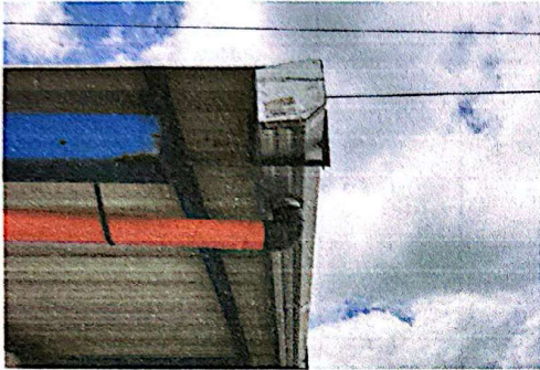
Foto 7: Suministro e intalación de canal pluvial de alto caudal.
