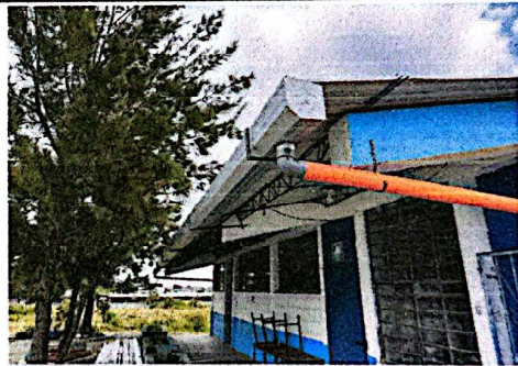
Foto 10: Canal pluvial de alto caudal.
