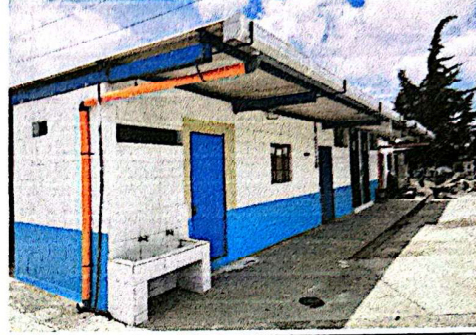
Foto 8: Tubería de PVC para descarga pluvial, con sus respectivos anclajes.
