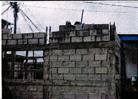
Foto 5: Levantado de Muro.
