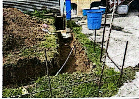
Foto 2: Zanqueo para cimentación de muros.
