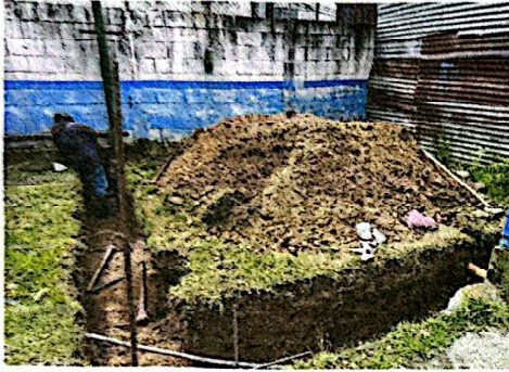
Foto 1: Trazo y excavación para ampliación de muros en cocina.
