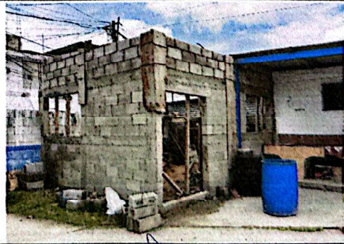
Foto 6: Levantado de muros.
