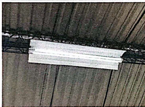
Foto 3: Suministro e instalación de lámparas tipo led para iluminación.
