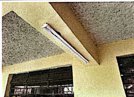
Foto 4 Suministro e instalación de lámparas en pasillo.
