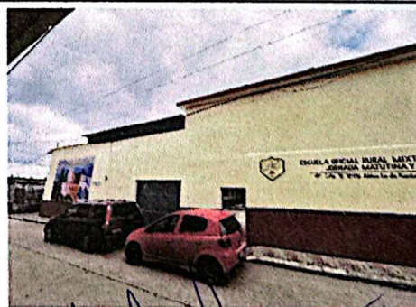
Foto 6: Aplicación de pintura en fachada.
