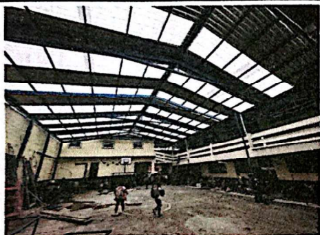
Foto 9: Aplicación de pintura anticorrosiva en estructura metálica de techo.
