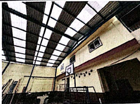
Foto 8: Ampliación de techo en cancha.
