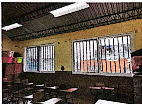
Foto 1: Suministro e instalación de Ventanas UPVC
