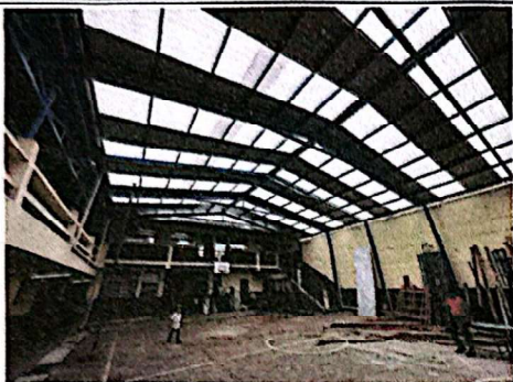
Foto 7: Suministro e instalación de lámina troquelada de aluzinc y policarbonato.
