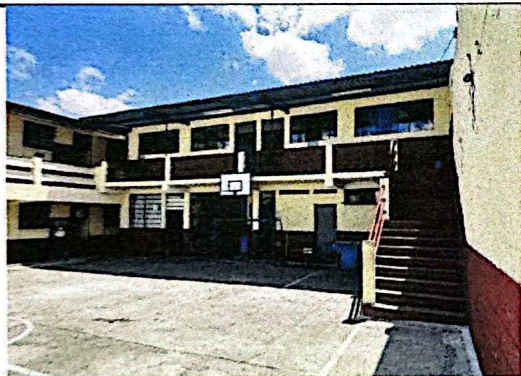
Foto 9: La ampliación del techo en el módulo B permitirá que los niños puedan movilizarse de manera segura en temporada de lluvia.
