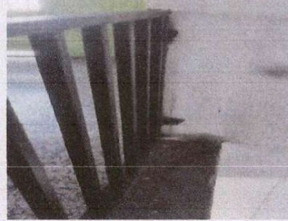
Foto.12 Reforzar 16 barandajes a las paredes iljarias y pintarias
