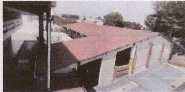
Foto 10. Mantenimiento al techo asegurando esquinas y tapando goteras .
