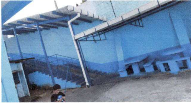
Foto19: Aplicación de pintura en muro perimetral de ingreso.
