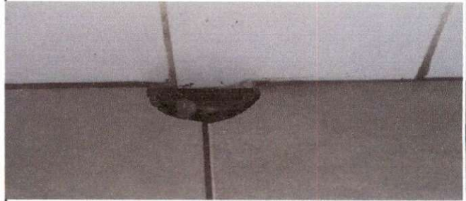
Foto 14: Destapar drenajes en área de baños.
