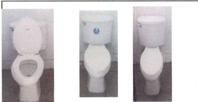
Foto 10: Se colocaron las tapaderas a los sanitarios para mayor higiene.
