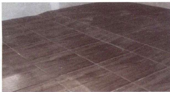
Foto 5: Se colocó piso cerámico como prevención al deterioro de la fundición.
