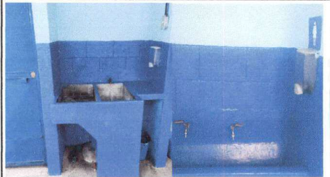
Foto 16: Se pintó el área de lavamanos y pila.
