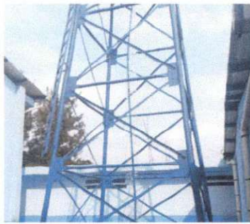
Foto 15: Reparación e instalación nueva ya que hay constante fuga el tinaco principal de agua.
