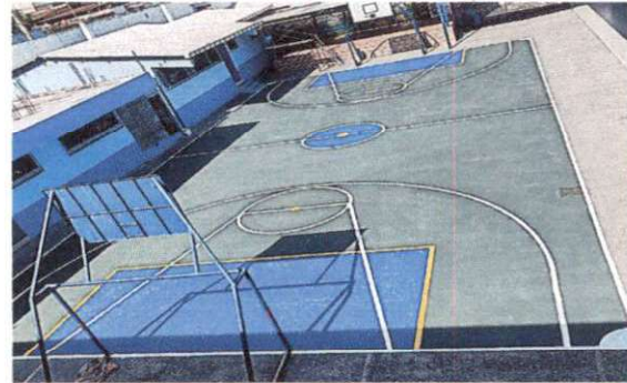
Foto 20: Aplicación de pintura en cancha y marcaje.
