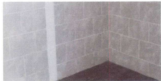
Foto 6: Se colocó azulejo para poder mantener una adecuada higiene en la cocina.
