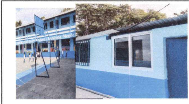
Foto 8: Aplicación de pintura en el exterior de salones. Interior de cocina y exterior.
