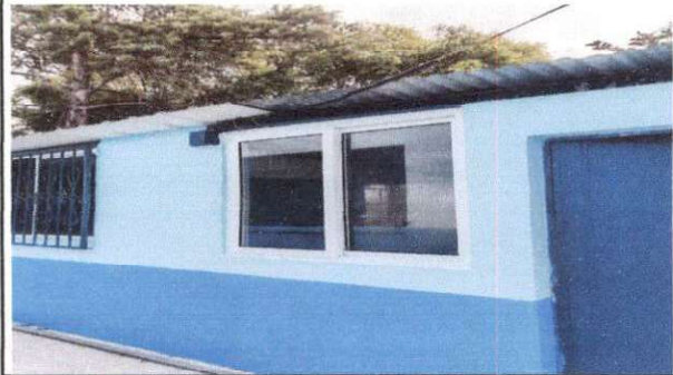
Foto 2: Se colocaron las ventanas correspondientes.
