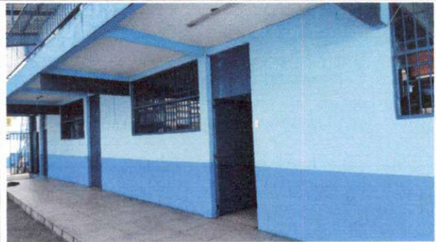
Foto 22: Aplicación de pintura.
