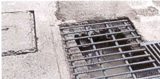
Foto 21: Mantenimiento de drenajes.
