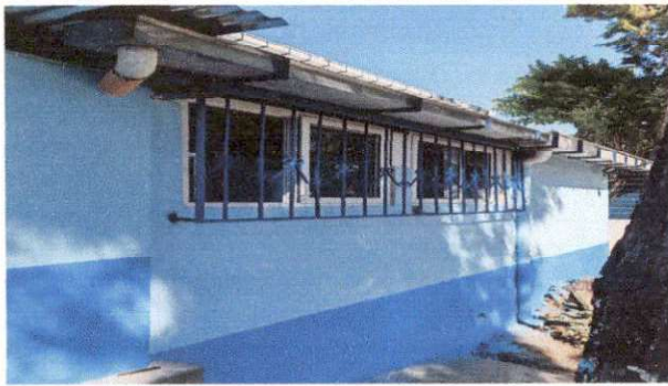
Foto 3: Se colocaron las ventanas en la cocina en la parte de atrás con sus respectivos balcones para mayor seguridad.
