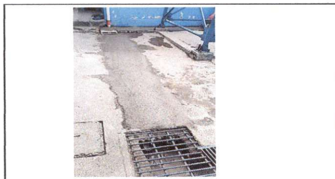
Foto 12: Se modificaron las bajadas de agua para evitar mantener el área húmeda y resbalosa.
