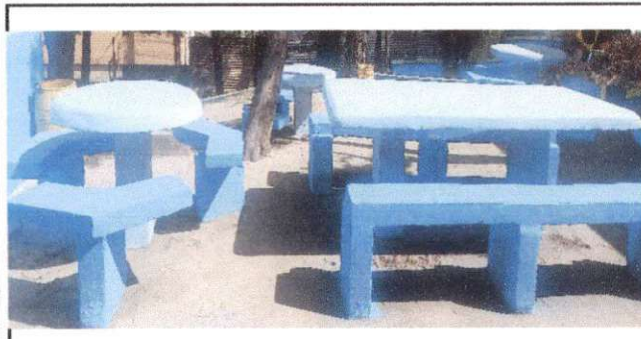
Foto 9: Aplicación de pintura en mesas y bancas de cemento.
