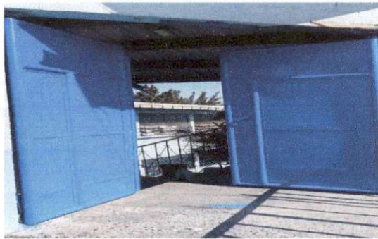
Foto 17: Pintura y lijado de portón de ingreso principal.
