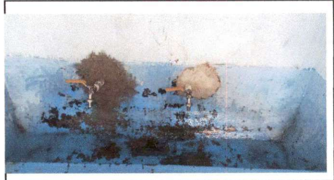
Foto 16: Pintura en área de lavamanos y pila.
