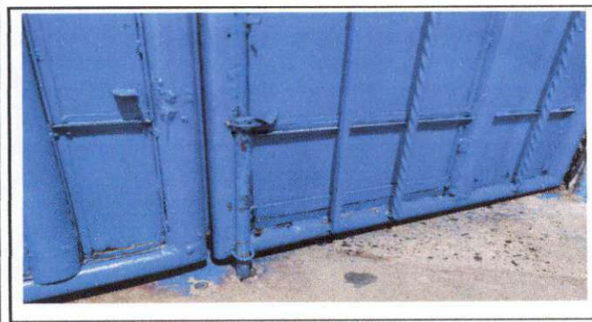
Foto 17: Pintura y lijado de portón de ingreso principal.
