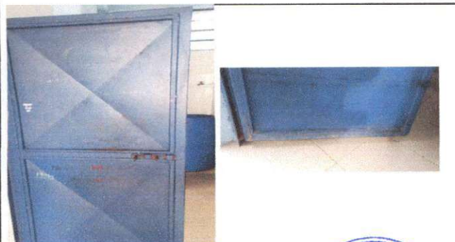
Foto 11: Aplicar pintura a las puertas de los sanitarios.
