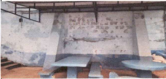
Foto19: Aplicación de pintura en muro perimetral de ingreso.
