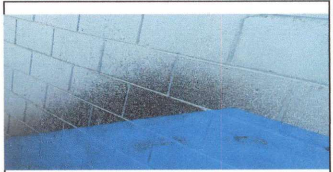
Foto 8: Aplicación de pintura en el exterior de salones. Interior de cocina y exterior.
