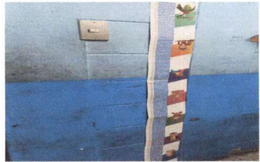
Foto 22: Aplicación de pintura.
