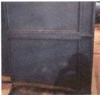
Foto 23: Pintura en puertas.
