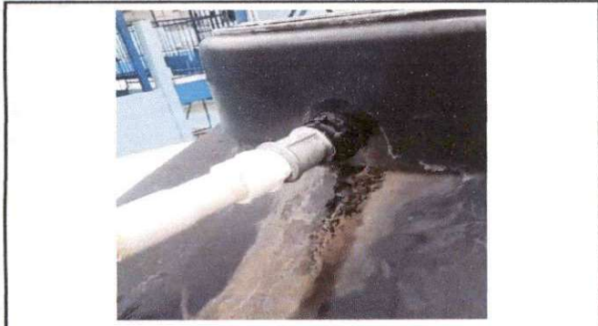
Foto13: Cambio de toda la instalación y reparación del tinaco.
