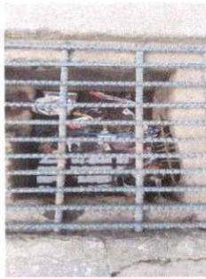
Foto 21: Mantenimiento de drenajes.
