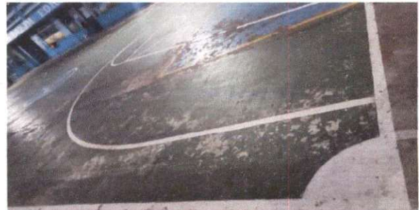
Foto 20: Aplicación de pintura en cancha y marcaje.
