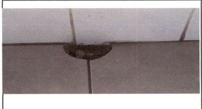
Foto 14: Destapar drenajes en área de baños.
