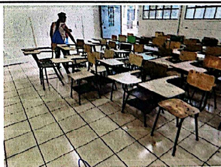
Foto 6: Suministro e instalación de piso cerámico.
