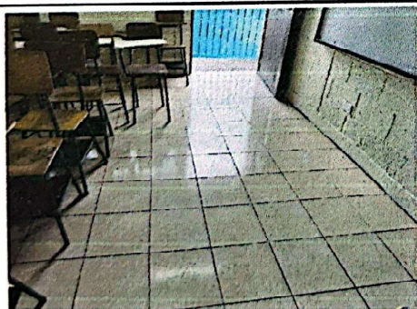
Foto 5: Suministro e instalación de piso cerámico.
