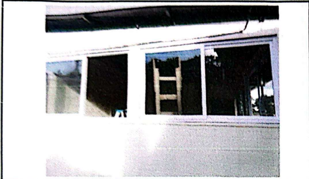
Foto 7: Suministro e instalación de ventanas corredizas UPVC.
