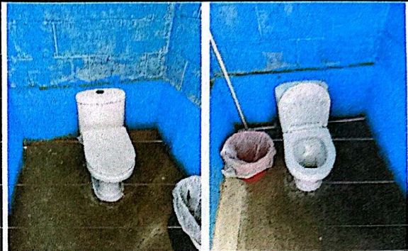
Foto 8: Suministro e instalación de inodoros pequeños para Pre-primaria.
