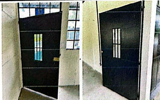
Foto 5: Mantenimiento a puertas metálicas, incluye lijado y pintura.
