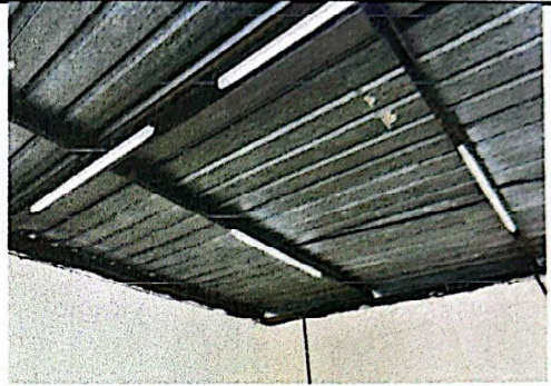
Foto 2: Suministro e instalación de red eléctrica de iluminación.
