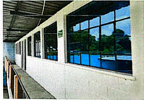
Foto 4: Aplicación de pintura en exterior de aulas modulo A
