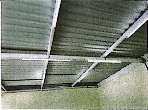
Foto 7: Suministro e instalación de luminarias.
