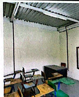
Foto 6: Red eléctrica, iluminación y fuerza + pintura interna.
