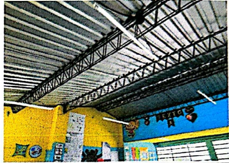
Foto 8: Instalación de lámparas nuevas, incluye cableado.
