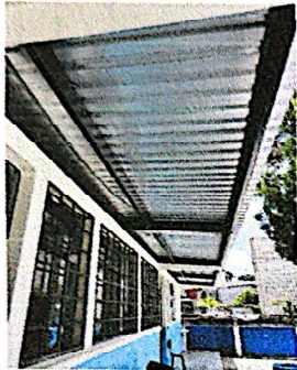
Foto 7: Instalación de láminas troqueladas nuevas.
